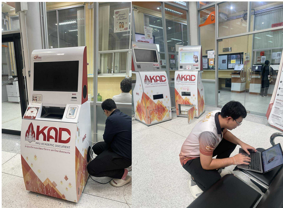
ภาพที่ 6 การติดตั้งระบบและตู้เอกสาร
